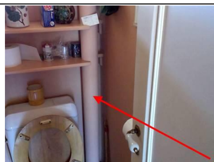
Photo n° PhA001 Localisation : Wc Ouvrage : Conduits de fluides (air, eau, autres fluides) Partie d'ouvrage : Conduits Description : Conduits Localisation sur croquis : M001
