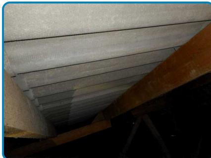
Plafond Plaques fibres ciment (dans 2ème étage Combles)
