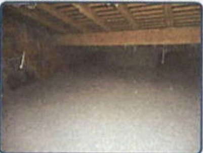
Maison principale 1er étage Combles
