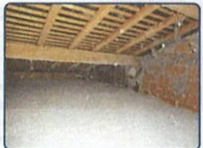
Maison principale 1er étage Combles2
