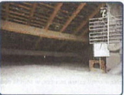
Maison principale 2ème étage Combles
