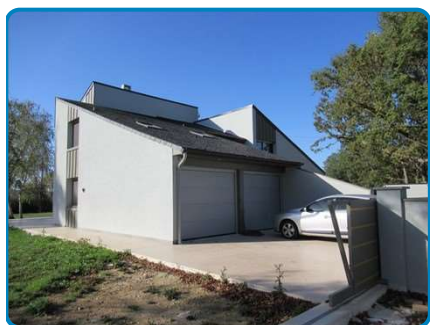
Maison principale Rez de chaussée Extérieur
