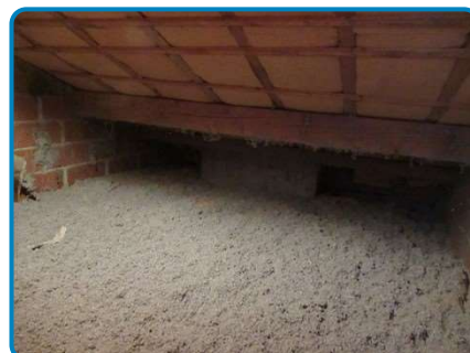
Maison principale 1er étage Combles
