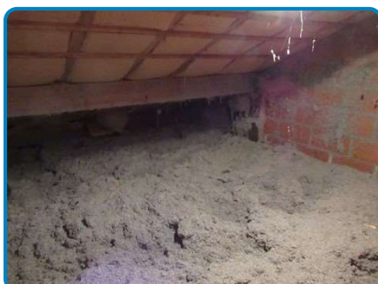
Maison principale 1er étage Combles2
