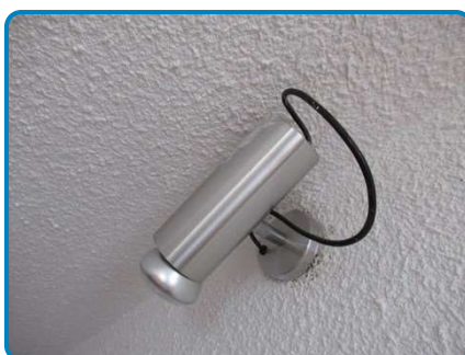
Anomalie B.6.3.1 a sur Install. n°1 App. n°2 Anomalie B.5.3 a sur Install. n°1 App. n°2
