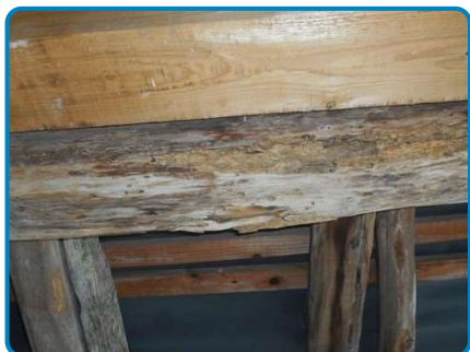
Plafond Charpente bois (dans 1er étage Fenil)
