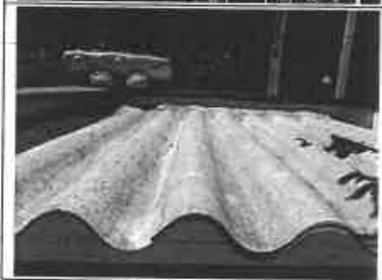
Photo n° A002 Localisation : annexe - appentis Ouvrage : 1. Toiture, terrasse et étanchéité - Plaques ondulées et planes Partie d'ouvrage : Plaques en fibres-ciment Description : Plaques en fibres-ciment
