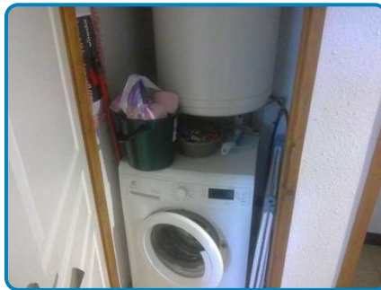
Appartement 1er étage Buanderie
