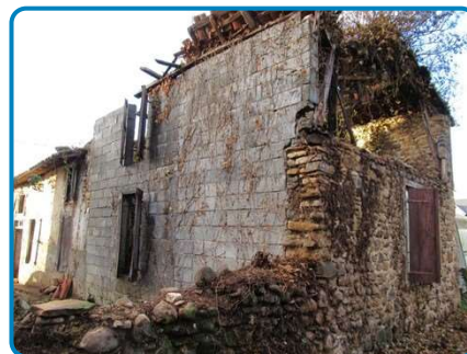
Maison Rez de chaussée Extérieur
