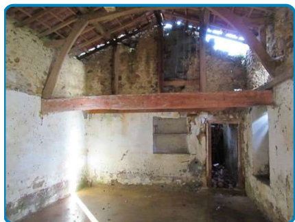
Maison Rez de chaussée Débarras n°1
