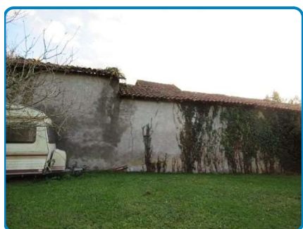
Maison Rez de chaussée Extérieur
