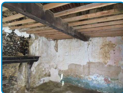
Maison Rez de chaussée Débarras n°2
