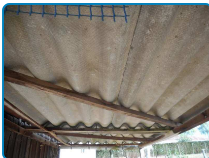
Plafond Plaques fibres ciment (dans Dépendance Rez de chaussée Auvent)
