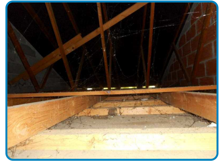
Maison principale 1er étage Comble garage
