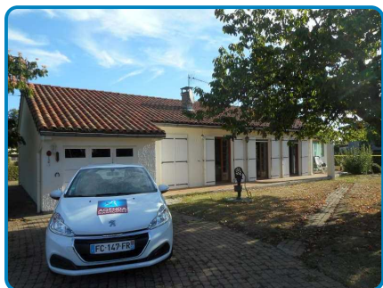
Maison principale Rez de chaussée Extérieur
