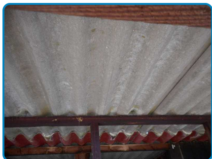
Plafond Plaques fibres ciment (dans Dépendance Rez de chaussée Poulailler)
