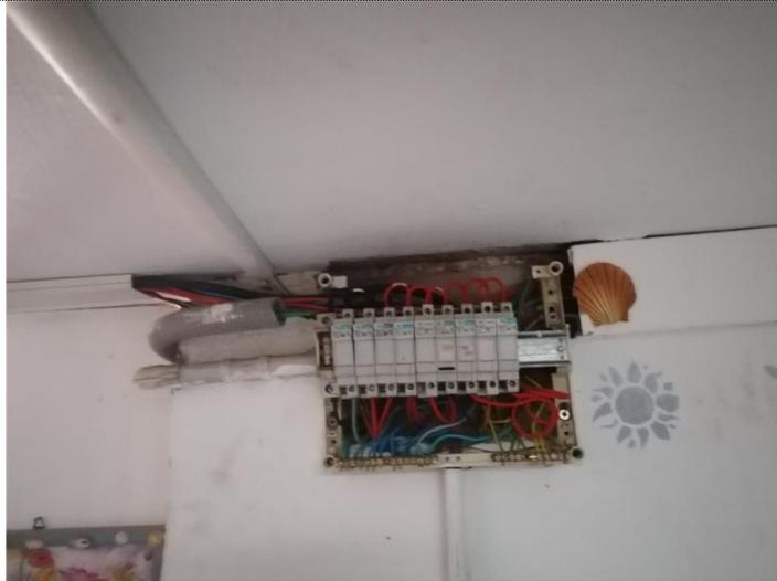
**Description :** Plusieurs CIRCUITS disposent d'un CONDUCTEUR NEUTRE commun dont les CONDUCTEURS ne sont pas correctement protégés contre les surintensités.
