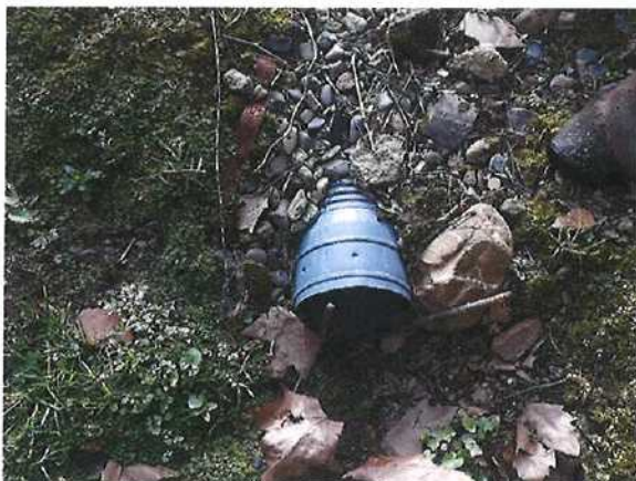
Départ du fossé busé mitoyen
