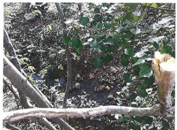
Exutoire du fossé busé mitoyen
