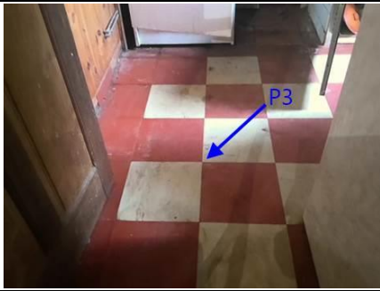
Photo n° PhA003 Localisation : Rez de chaussée - Cuisine Ouvrage : 5 - Planchers et planchers techniques - Revêtements de sols Partie d'ouvrage : Dalle de sol Description : Dalle de sol
