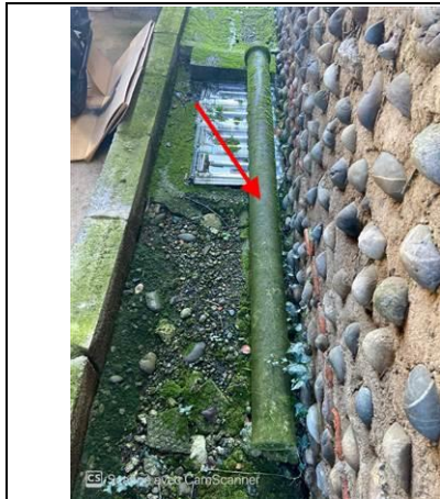
Photo n° PhA003 Localisation : Extérieur - Cour Ouvrage : Conduites en toiture et façade Partie d'ouvrage : Conduites d'eaux usées en amiante-ciment Description : Conduites d'eaux usées en amiante-ciment Localisation sur croquis : ZPSO-003
