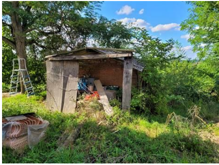
Photo n° PhA004 Localisation : Dépendances - Abris 2 Ouvrage : Toitures Partie d'ouvrage : Plaques (fibres-ciment) Description : Plaques (fibres-ciment)
