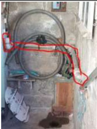
Photo n° PhA007 Localisation : Sous-Sol - Cave Ouvrage : 3. Conduits, canalisations et équipements intérieurs - Conduits de fluides (air, eau, autres fluides) Partie d'ouvrage : Conduits Description : Conduits
