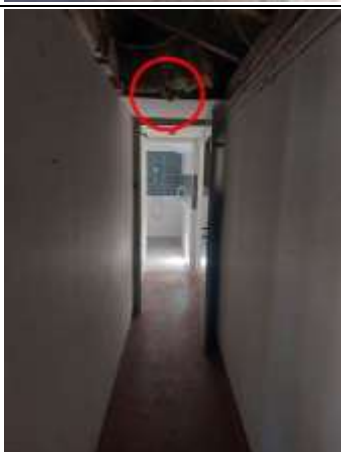
Photo n° PhA008 Localisation : Rez de chaussée - Dégagement Ouvrage : 2. Planchers et plafonds - Plafonds, Poutres et Charpentes, Gains et Coffres Horizontaux Partie d'ouvrage : Panneaux collés ou vissés Description : Panneaux collés ou vissés
