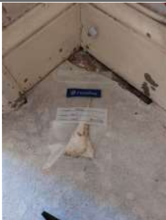
Photo n° PhA002 Localisation : Rez de chaussée - Chambre 2 Ouvrage : Substrats et revêtements Partie d'ouvrage : Parties accessibles Description : Sol - Sol plastique et revêtement plastique (lino)
