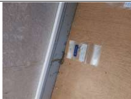
Photo n° PhA001 Localisation : Rez de chaussée - Entrée Ouvrage : Substrats et revêtements Partie d'ouvrage : Parties accessibles Description : Sol - Parquet et revêtement plastique (lino)
