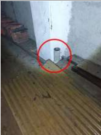
Photo n° PhA005 Localisation : Combles - partie coté rue Ouvrage : 3. Conduits, canalisations et équipements intérieurs - Conduits de fluides (air, eau, autres fluides) Partie d'ouvrage : Conduits Description : Conduits
