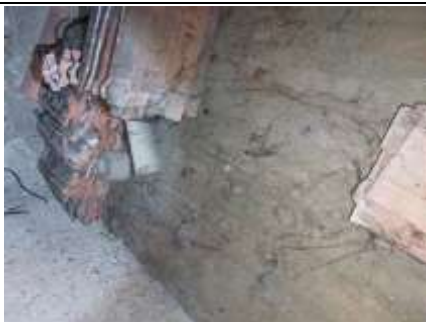
Photo n° PhA006 Localisation : Combles - partie coté rue Ouvrage : 3. Conduits, canalisations et équipements intérieurs - Conduits de fluides (air, eau, autres fluides) Partie d'ouvrage : Conduits Description : Conduits
