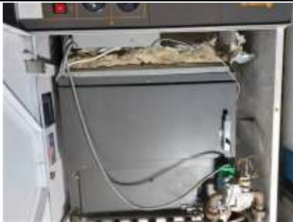
Photo n° PhA004 Localisation : Sous-Sol - Cave Ouvrage : 1. Flocages, Calorifugeages, Faux plafonds Partie d'ouvrage : Calorifugeages Description : Calorifugeages
