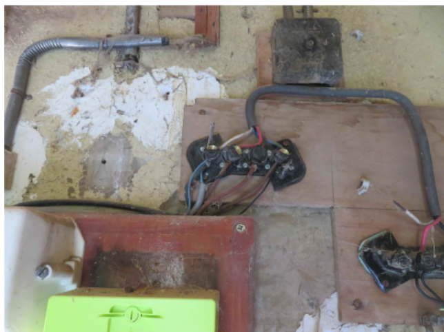
Connexion non protégé ( entrée pièce 1) et conduit fro
