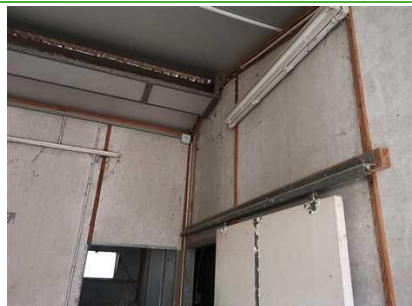
Photo n° PhA001 Localisation : Annexe - atelier Ouvrage : 3 - Parois verticales intérieures - Cloisons sèches (assemblées, préfabriquées) Partie d'ouvrage : Panneaux de cloisons lisses ou moulurées, préfabriquées ou non Description : Panneaux de cloisons lisses ou moulurées, préfabriquées ou non
