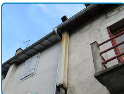
D.O. n° 2 sur Conduit(s) de fluide Fibres ciment
