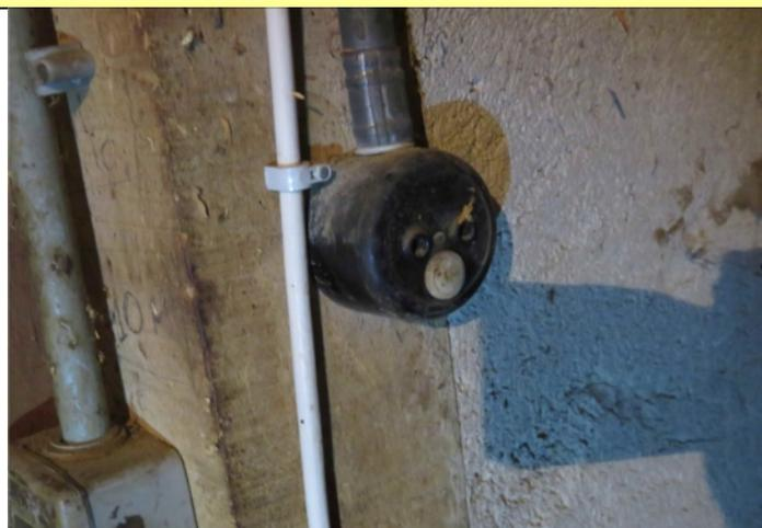
Prise simple sans broche de terre , non obturé et sans puits et avec fusible intégré
