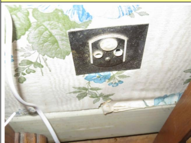
Prise simple sans broche de terre , non obturé et sans puits et avec fusible intégré et façade métallique
