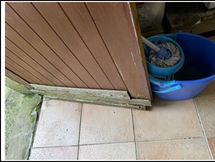
Photo n° PhTer001 Localisation : Rez de chaussée - Séjour Ouvrage : Porte (Bois) vers l'extérieur Parasite : Présence d'indices d'infestation d'autres agents de dégradation biologique du bois, ---- Insectes à larves xylophages ----
