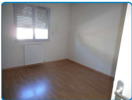
Rez de chaussée Chambre 3
