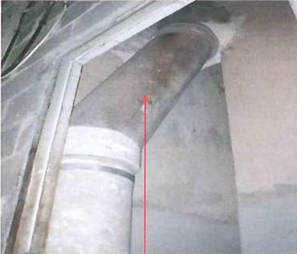
**Conduit de vide ordures en amiante ciment diam. 400 mm**
