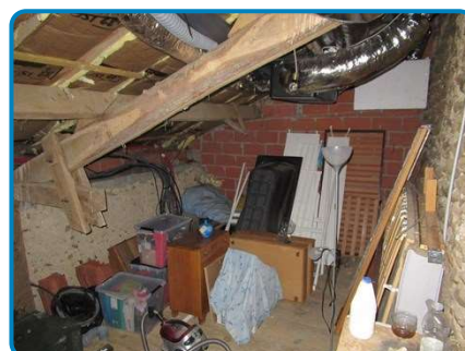
Maison principale 1er étage Grenier
