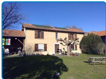
Maison principale Rez de chaussée Extérieur
