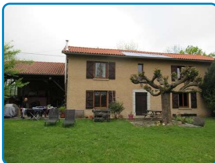
Maison principale Rez de chaussée Extérieur
