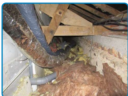
Maison principale 1er étage Grenier
