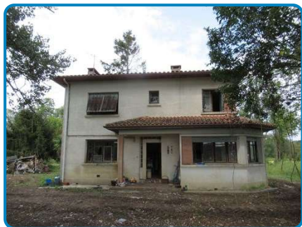
Maison principale Rez de chaussée Extérieur
