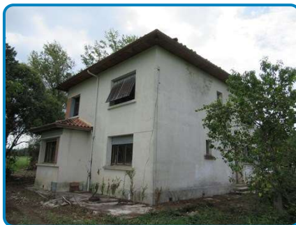
Maison principale Rez de chaussée Extérieur
