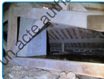
Maison principale 2ème étage Combles
