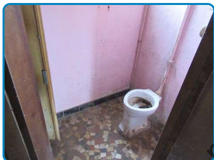
Maison principale Rez de chaussée WC
