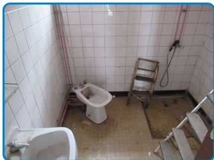
Maison principale 1er étage Salle d'eau
