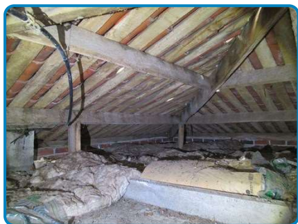
Maison principale 2ème étage Combles
