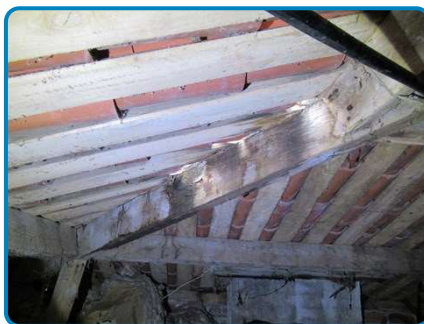
Maison principale 2ème étage Combles
