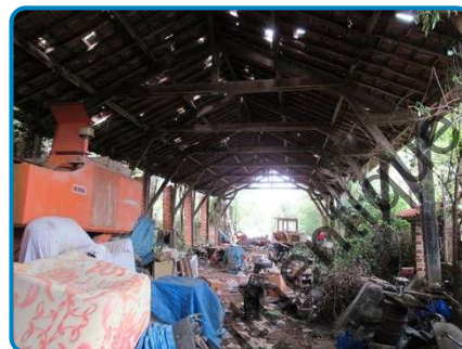
Dépendances Rez de chaussée Hangar
