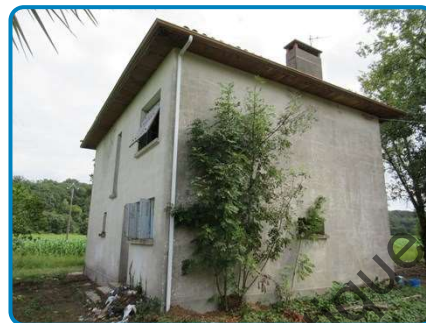
Maison principale Rez de chaussée Extérieur
