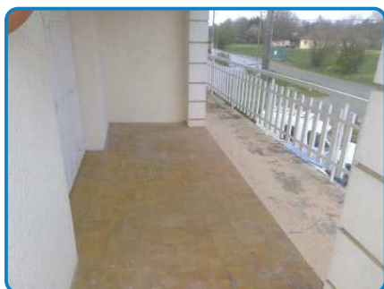
Maison principale 1er étage Terrasse
