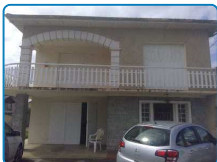
Maison principale Rez de chaussée Extérieur
