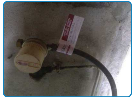
sur Install.n°1 : Fermeture totale avec pose d'une étiquette signalant la condamnation de l'installation de gaz
