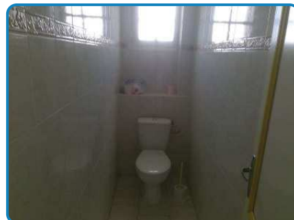
Maison principale 1er étage WC
