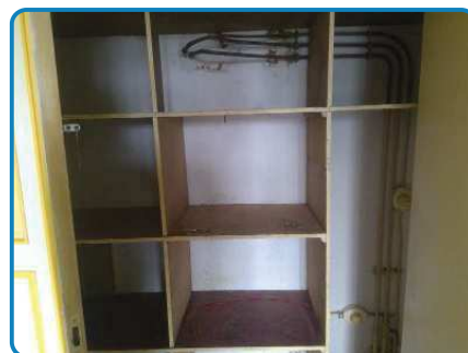
Maison principale 1er étage Placard
