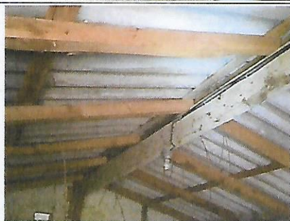
Photo n° PhA003 Localisation : Extérieur - Atelier Ouvrage : 1 - Couvertures, Toitures, Terrasses et étanchéités - Plaques ondulées et planes Partie d'ouvrage : Plaques en fibres-ciment (y compris plaques « sous tuiles ») Description : Plaques en fibres-ciment (y compris plaques « sous tuiles ») Localisation sur croquis : M003
