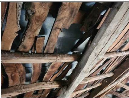
Photo n° PhA001 Localisation : Extérieur - Toiture Ouvrage : 1 - Couvertures, Toitures, Terrasses et étanchéités - Plaques ondulées et planes Partie d'ouvrage : Plaques en fibres-ciment (y compris plaques « sous tuiles ») Description : Plaques en fibres-ciment (y compris plaques « sous tuiles »)
