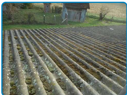
Toiture arrière cuisine Plaques fibres ciment (dans Maison principale Rez de chaussée Extérieur)
