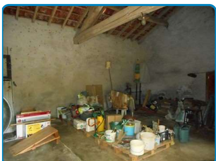
Dépendances Rez de chaussée Grange n°1
