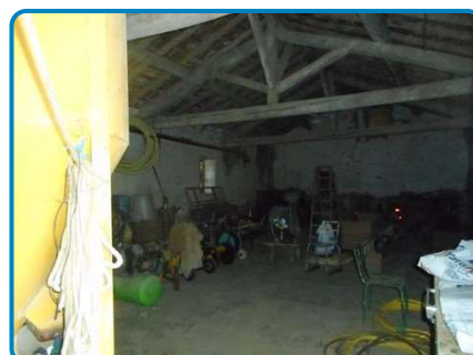
Dépendances Rez de chaussée Grange n°2
