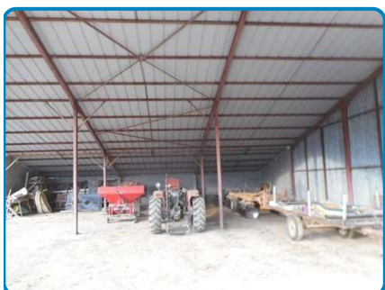
Dépendances Rez de chaussée Hangar
