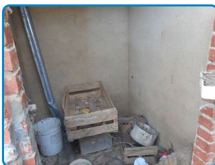
Dépendances Rez de chaussée WC
