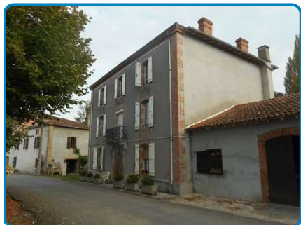
Maison principale Rez de chaussée Extérieur
