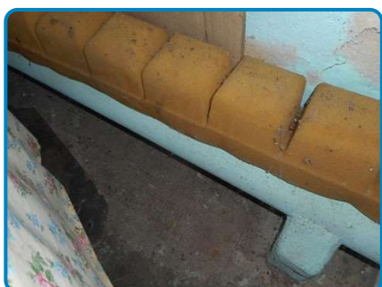
Conduit(s) de fluide Fibres ciment (dans Maison principale Rez de chaussée Arrière cuisine)
