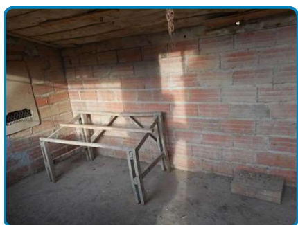
Dépendances Rez de chaussée Poulailler n°1
