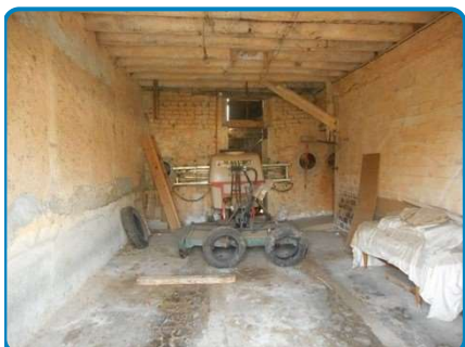
Dépendances Rez de chaussée Garage n°1
