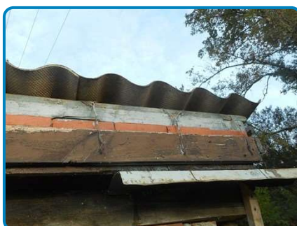
Toiture poulailler Plaques fibres ciment (dans Dépendances Rez de chaussée Extérieur)
