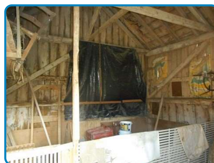
Dépendances Rez de chaussée Poulailler n°2
