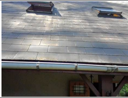
Photo n° PhA001 Localisation : Parties extérieures parties gauche Ouvrage : 4. Eléments extérieurs - Toitures Partie d'ouvrage : Ardoises (fibres-ciment) Description : Ardoises (fibres-ciment)
