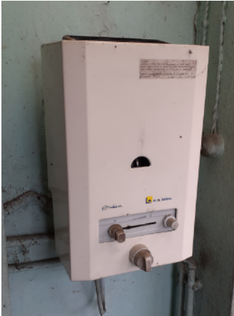
Chauffe eau gaz
