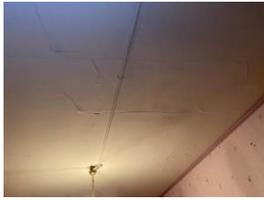
Présence de fissures sur le plâtre des plafonds de l'étage
