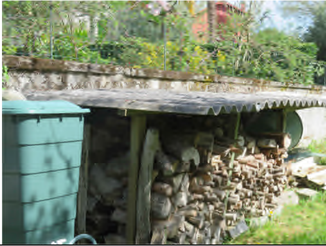
Plaques ondulées en amiante ciment en couverture abris bois
