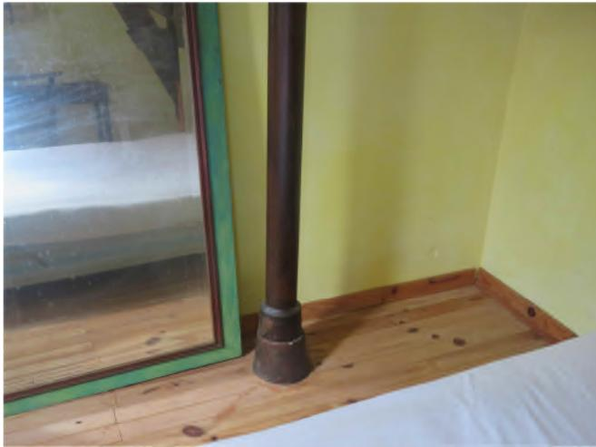
Conduit de ventilation en amiante ciment chambre 3
