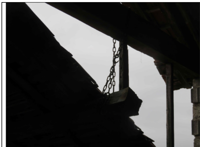
Charpente fragilisé dépendance : panne en suspension avec chaine de maintien
