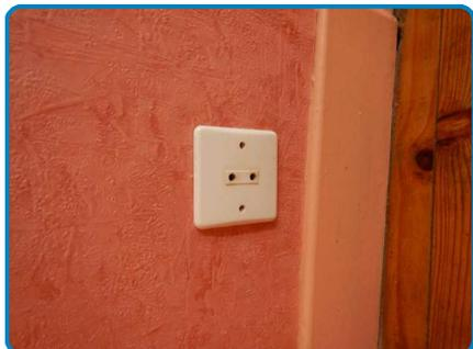
Aucun dispositif différentiel à haute sensibilité  $\leq 30$  mA (Salle à manger)
